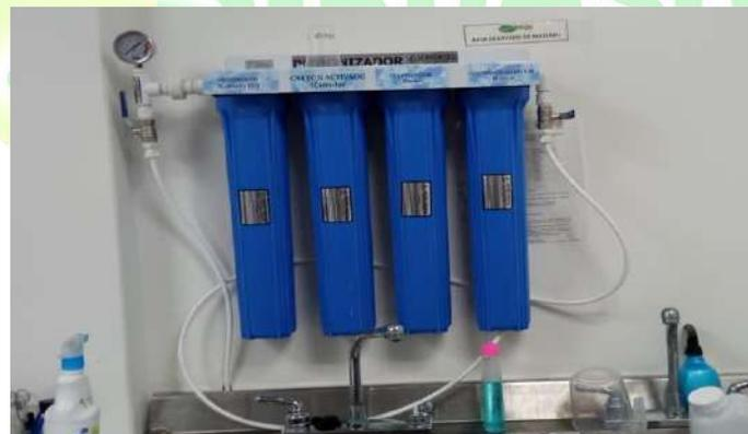
Desionizador de Agua para el Equipo de Química Automatizado
