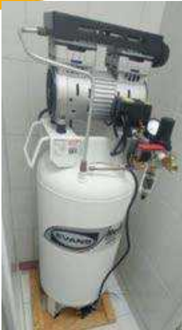
Registro fotográfico: Instalación Compresor de Aire Seco
