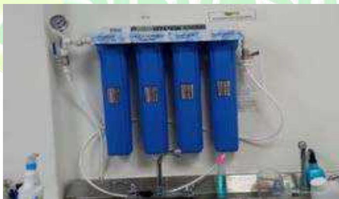
Registro fotográfico: Instalación de Desionizador de Agua para el Equipo de Química Automatizado
