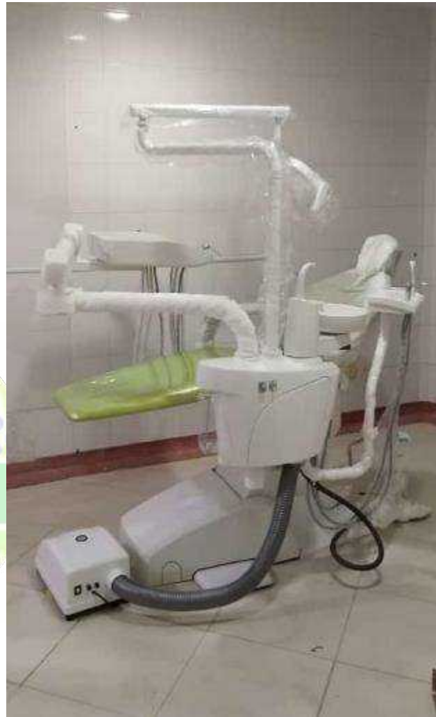
Registro fotográfico: Instalación de Unidad Odontológica
